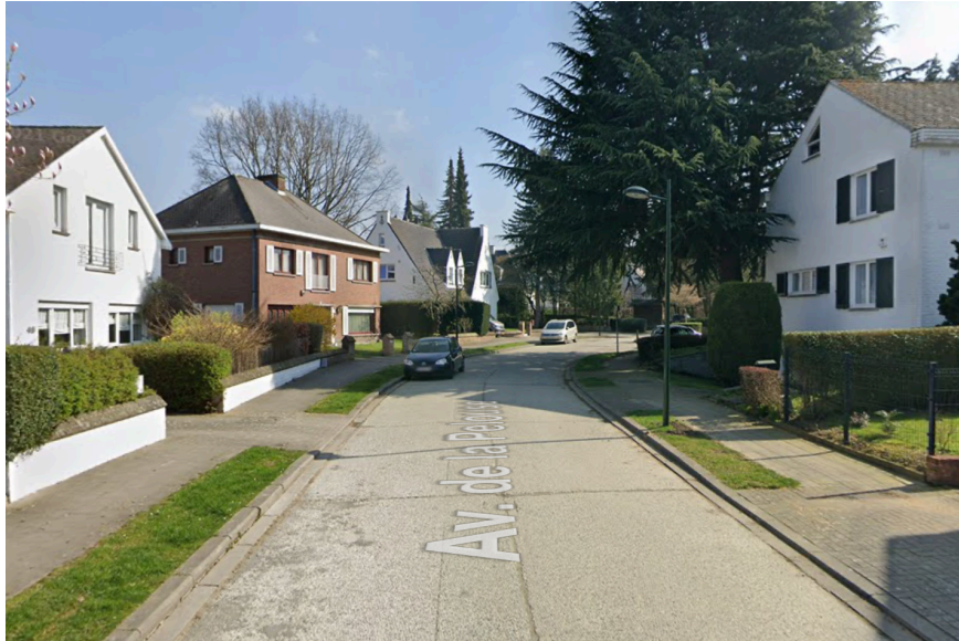
Figure 10 : exemple de voirie « moyennement facile » à déconnecter, avenue de la pelouse
