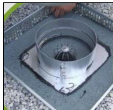
Figure 46 : Limiteur de débit en toiture (Débit-co)
