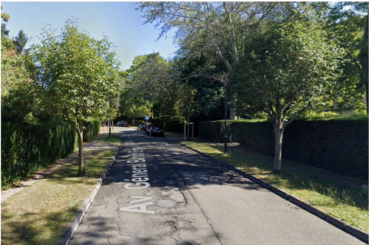
Figure 9 : exemple de voirie « facile » à déconnecter, avenue du Général Baron Empain
