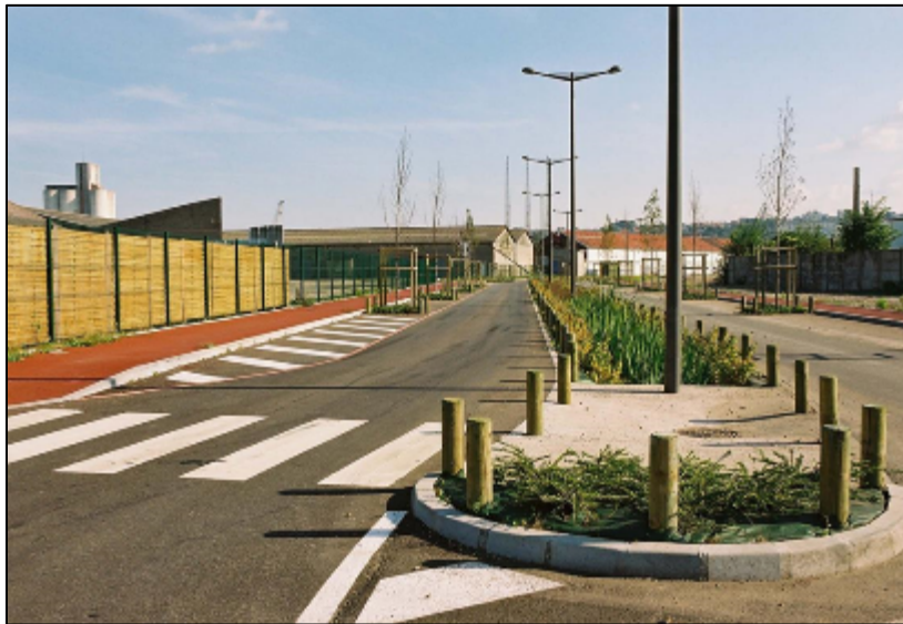
Figure 36 : Photo d'une noue centrale plantée (IS)
