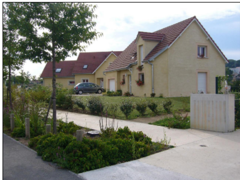
Figure 35 : Photo d'une noue plantée avec piétonnier (IS)
