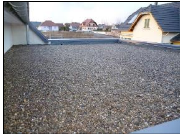
Figure 42 : Toiture gravillonnée (soprema)
