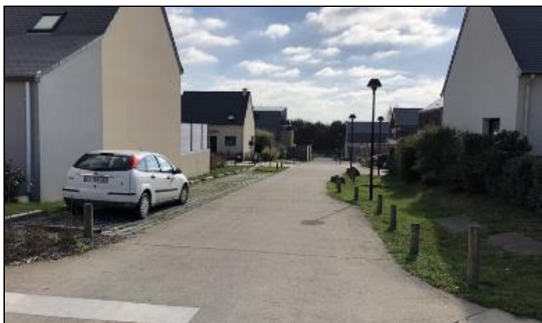
Figure 38 : Photo d'une voie de lotissement en structure drainante (IS)
